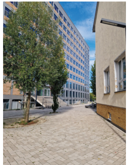
Fotos vom THM-Gebäude Wiesenstraße 14.
