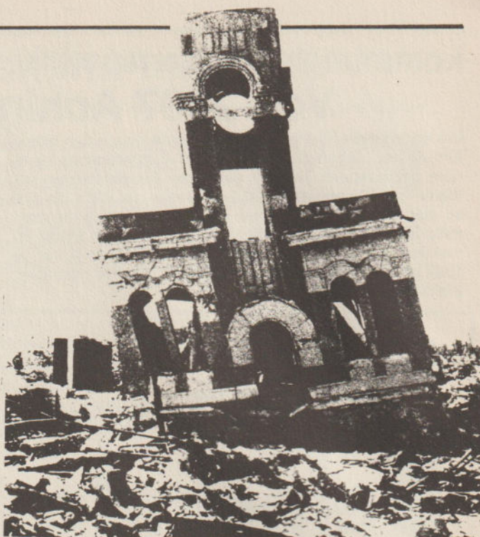
Der Uhrenturm von Shimomura Tokei-ten in Hiroshima, 700 Meter östlich des Hypozentrums, ist durch die Druckwelle, die ihn von der Seite traf, zusammengeknickt. Foto: Shigeo Hayashi.
